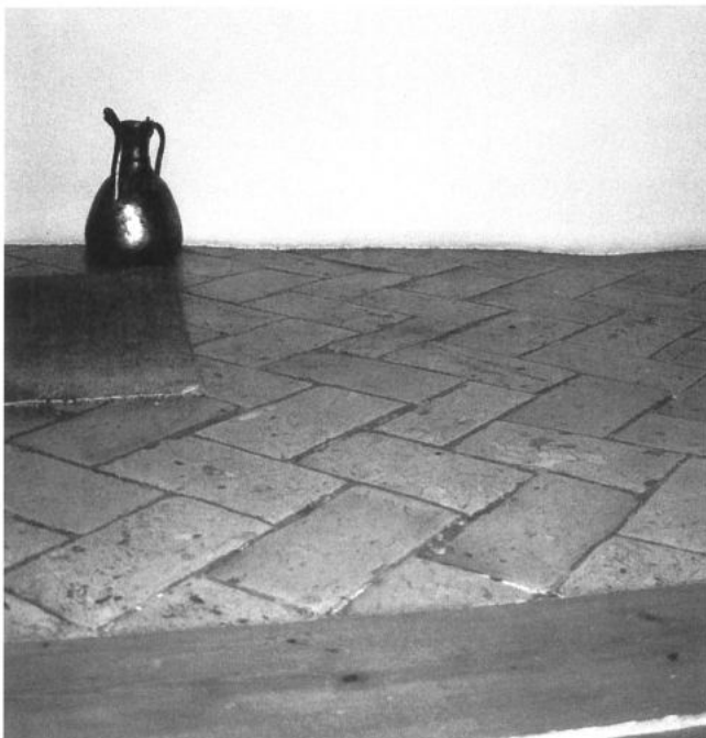
Im Gang sind die Züriziegel im Fischgratmuster verlegt.
