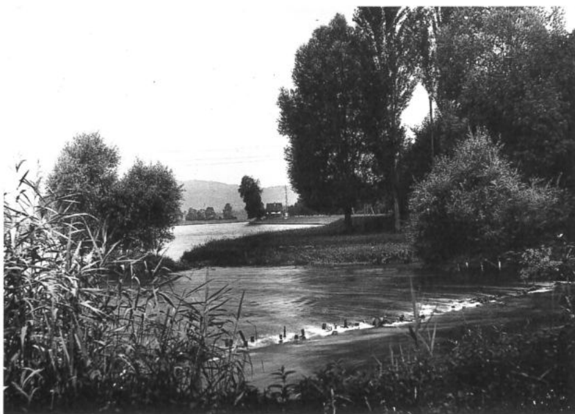
Das Wuhr beim Inseli, d.h. beim alten Landeplatz im Einlaufgebiet des Klosterkanals. Die Wuhung ist noch mit Holzpfehlen und mit grossen Feldsteinen erstellt (um 1940). (OM)
