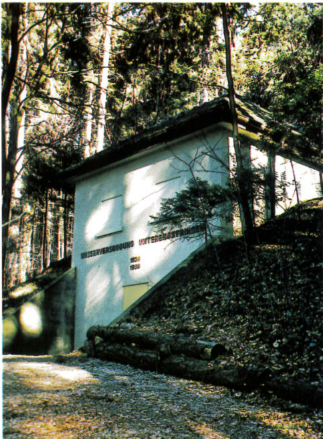
Das zweite Reservoir der Gemeinde wurde 1938 im «Ischlag» gebaut.
