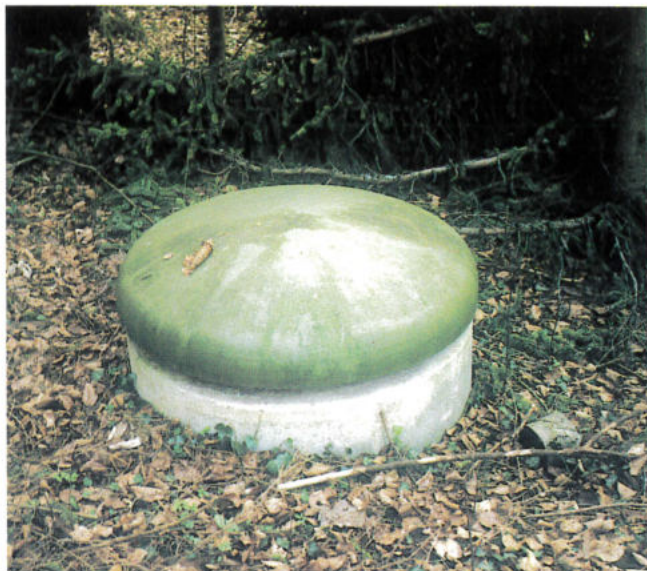
Sabotagesichere Brunnenstubendeckel bezeichnen die verschiedenen Quelfassungen.
