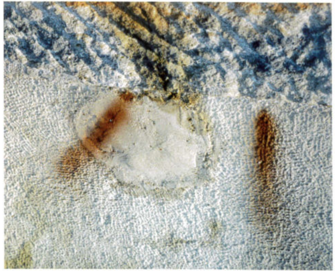
Eine «zugepflasterte» Schiesscharte in der Stirnseite des linken Brückenkopfes von einem Maschinengewehr-Nest ist an der Limmat das letzte Relikt der Befestigungen der Limmatverteidigungslinie des 2. Weltkrieges.
