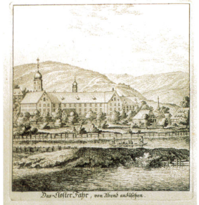
Der Stich vom Kloster Fahr (JOHANN BALTHASAR BULLINGER 1760) zeigt, wie auch dort die Ufer der Limmatarme mit Wuhungen aus Holzpfählen, Faschinen und Brettern gegen Landverlust bei den häufigen Hochwassern geschützt werden mussten.
