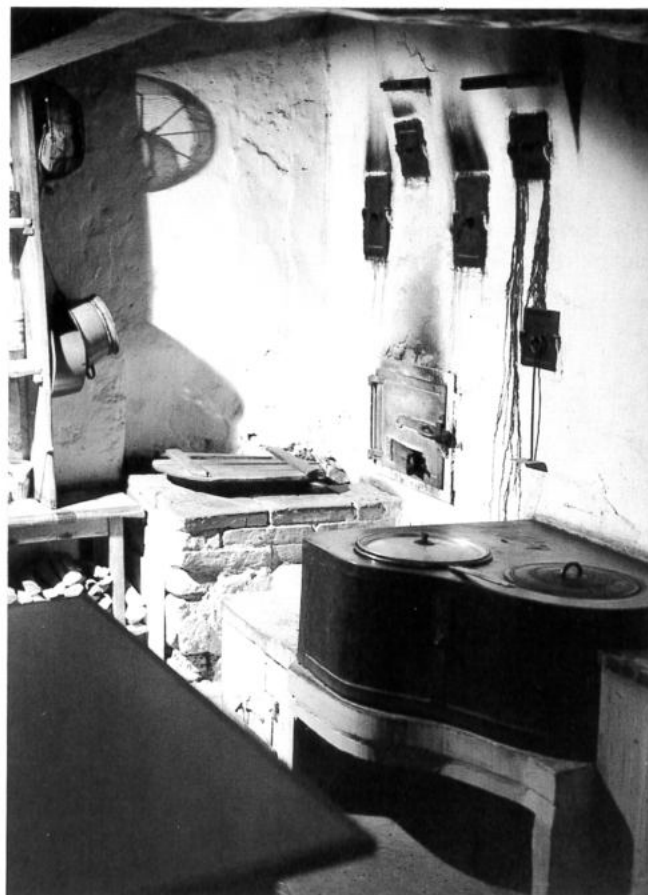
Die Küche im Hausteil SCHWERZMANN war 1978 im Zustand wie 100 Jahre zuvor. Der zweilöcherige Holzkochherd war noch ohne das sonst übliche Wasserschiff, wo man dauernd heisses Wasser zur Verfügung hatte. Vor der grossen Ofentüre zum Einheizen des Kachelofens ist die «Aschentolle» für grössere Aschenmengen aufgemauert, damit man im Winter genügend Aschenvorrat zum Ausstreuen (anstelle des heutigen Streusalzes) zur Verfügung hatte. O. M.
