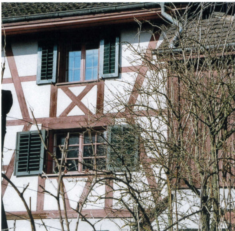
Südfront des Hauses SCHMIDER mit dem schlichten Riegelwerk.
