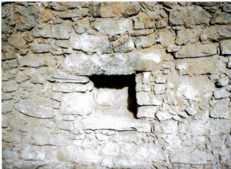
Als 1834 die Gubristwaldung in den Besitz der Holzkorporation überging, konnten die Bauherren im Steinbruch oberhalb des Sparrenbergs gratis qualitativ guten Sandstein für den Eigenbau brechen. Da der Sandstein in Schichten abgelagert ist, ergaben sich beim Ausbeuten auf einfache Weise rechteckige Brocken, die gut vermauert werden konnten und daher als Gratisbaumaterial im Dorf überall Verwendung fanden.
