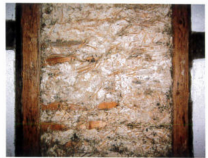
Im Hausinnern verwendete man zum Ausmauern eine Konstruktion aus einem Raster von gespaltenen «Holzriegeln», die mit in Mörtel gedrehten Strohzöpfen aufgeplästert wurden (Chläggihaus). O.M.
