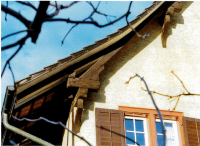
Flugsparrenkonstruktion am Hause GOHL.
