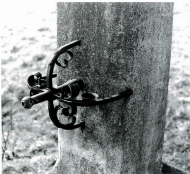
Die mit einer Schmiedeisenzier fixierte Brunnenröhre des Hofbrunnens entspricht derjenigen der ersten Laufbrunnen der Gemeinde und dürfte von 1774 stammen.
