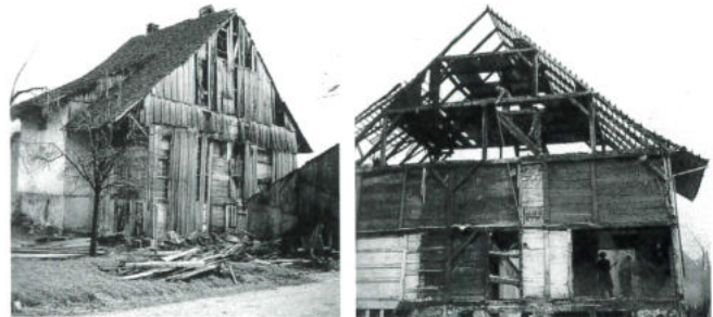
Die Bohlenständer-Wetterfassade war behelfsmässig mit Brettern abgedeckt. Beim Abbruch des Gebäudes kamen interessante Konstruktionsteile des ursprünglichen Bohlenständerbaus zum Vorschein.
