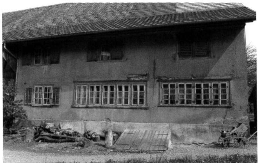
An der Südseite des GNEPFEN-Hauses (Aufnahme 1981) lag der Treppenabgang zum grossen Fasskeller. Alle Kellereingänge auf der Südseite der Häuser waren mit Bretter-Ballen abgedeckt, damit die Sonne nicht an die Kellertüren schien und die Keller auch im Sommer kühl blieben. P.W.
