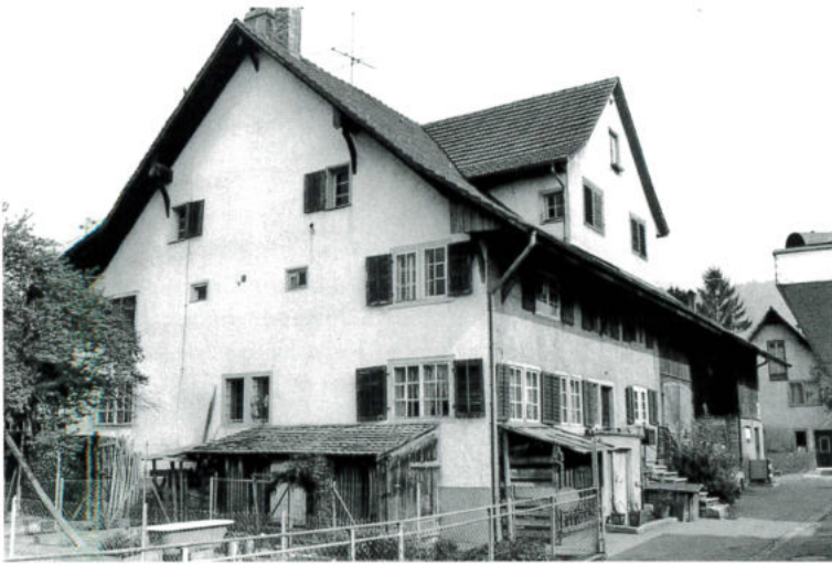
Das Doppelhaus EHRSAM/HOLLENWEGER war absolut symmetrisch gebaut und «dem First nach» getrennt. P.W. 1981
