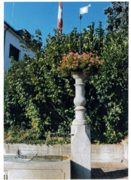
An der Brunnenstud des mittleren Dorfbrunnens sind die Ergänzungen der unteren Partie aus dem Jahre 1930 offensichtlich.
