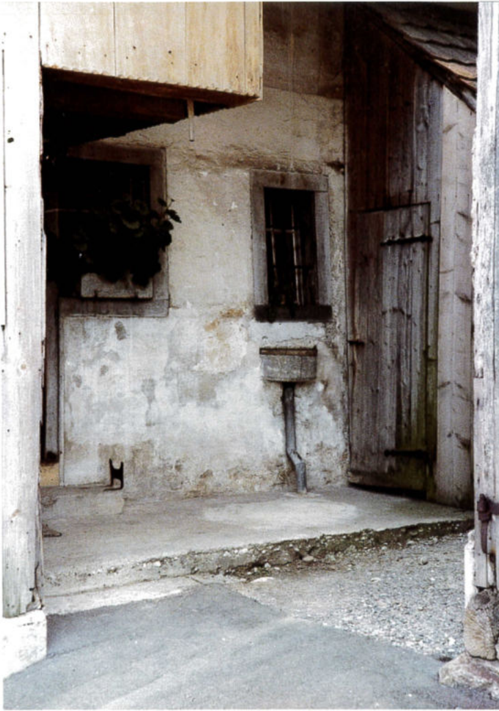
Der äussere Teil des Schüttsteins führte das Waschwasser zum Fallrohr und wie der Abort rechts davon, in die Jauchegrube. O.M. 1978
