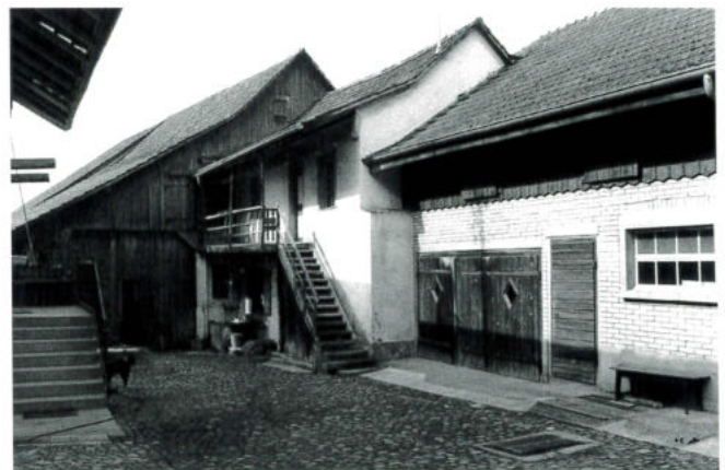
Blick in den Hofraum der Liegenschaft HOLLENWEGER (Dorfstrasse 9). Im Zentrum die gemauerte Brennerei mit der «Knechtenwohnung» im ersten Stock. P.W. 1981
