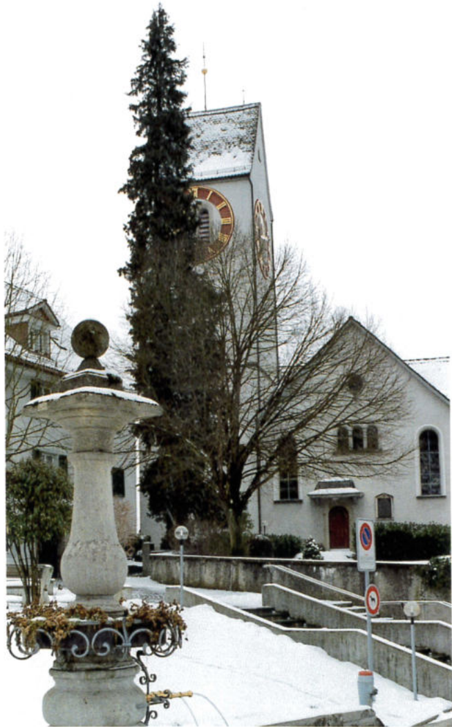
Der Dorfbrunnen bei der Kirche Weiningen hat eine gleichartige Brunnenstud wie der mittlere Dorfbrunnen in Unterengstringen auf der Foto aus dem Jahre 1914.
