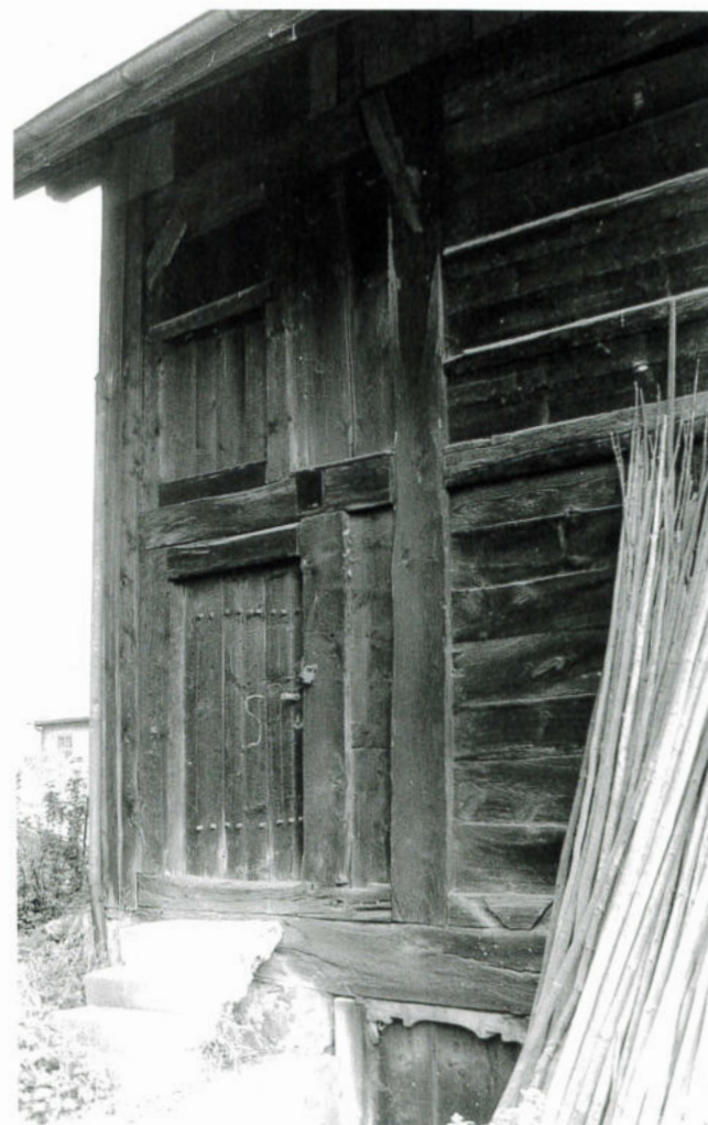
Der Speicher ist im Westteil als zweigeschossiger Bohlenständerbau erstellt worden. Er wurde 1902/03 unterkellert und neu eingedeckt. Die ursprüngliche Holzterrasse ist leider gestohlen worden.
