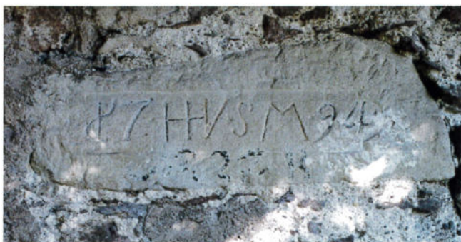
Typisch für die Ackersteinmauern – vor allem der Waschhäuschen – sind die Steine früherer Bauten, so z.B. einer von 1794 am Waschhäuschen GOHL.
