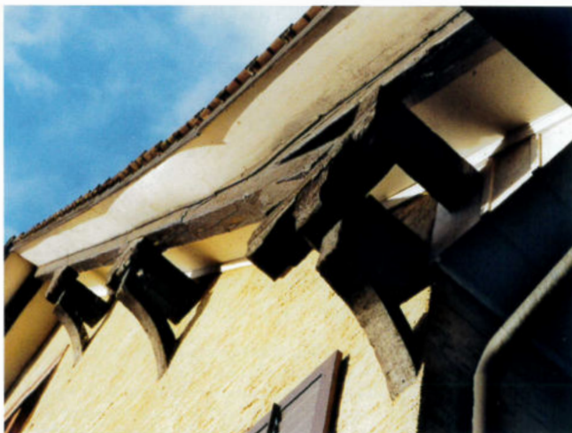
Flugsparrenkonstruktion am Hause GOHL.
