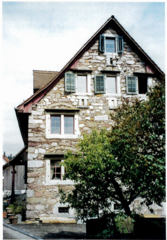
Die Wetterschutzmauer des Hauses SCHMIDER aus dem Jahre 1735 wurde 1779 mit neuen Fenstergewänden «aufgemöbelt», ist aber sonst noch authentisch vorhanden.
