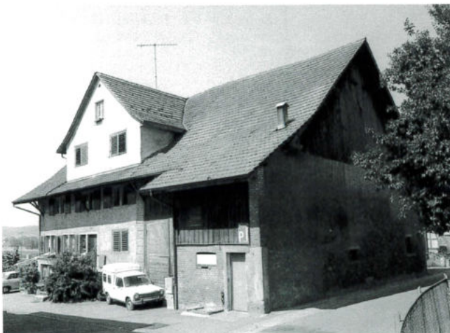
Der Hausteil EHR SAM (Dorfstrasse 7) P.W. 1981
