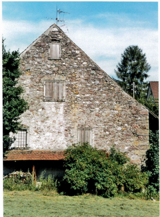
Die Südflanke der Wettermauer ist weitgehend mit Sandsteinquadrern aus dem Steinbruch am Gubrist aufgezogen. Die Schutzwand ist sonst mit erstaunlich kleinen Feldsteinbrocken gemauert. Der grossfruchtige Holderbusch wird leider von einem wuchernden Ahorn verdrängt und hat schon besser Zeiten erlebt.
