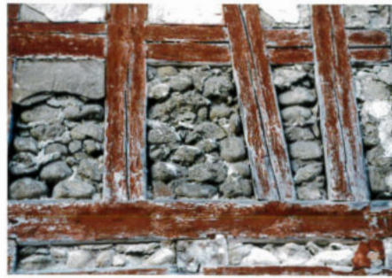
Die Fächer der Fachwerkbauten sind nur selten mit Bollensteinen ausgefüllt worden, da sie mehr Kalkmörtel erforderten als verkeilte Bruchsteine (Fahrweidhof).
