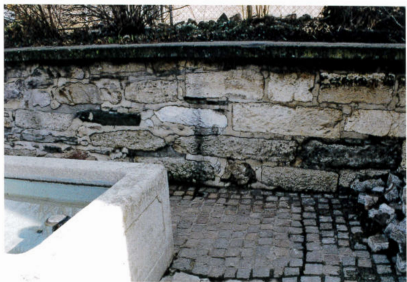
In der Abgrenzungsmauer des vorderen Dorfbrunnens sind im Jahre 1904 Kalksteinblöcke von der Läger eingebaut worden, die eigentlich für die Ufermauern des begradigten Limmatlaufes hätten verwendet werden sollen (oben rechts).
