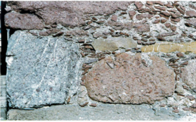
Die grossen Findlinge sind am Fundort in handhabbare Blöcke zerkleinert worden, wobei auch die kleinen Bruchstücke gesammelt wurden. Sie bildeten ein gutes Material zum Verkeilen der grossen Steine und als Füllmaterial (Haus SCHMIDER).
