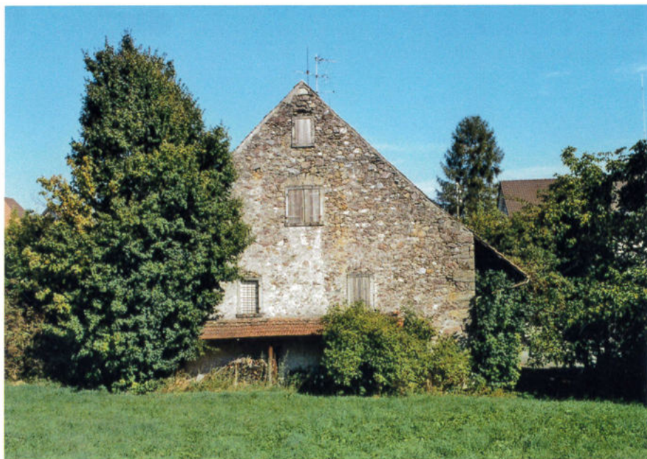
Die Wetterschutzmauern aus Ackersteinen an der Westfront der Dreisässenhäuser sind typisch für Unterengstringen. Auf den Äckern der Endmoräne nordwestlich des Dorfes hemmten viele eratische Blöcke (Findlinge) das tiefgründige Pflügen und die Feldarbeiten. Diese Ackersteine bildeten daher das ideale Baumaterial. Die Wetterschutzmauer des Wagner-Heiri-Hauses wurde später teilweise verputzt.
