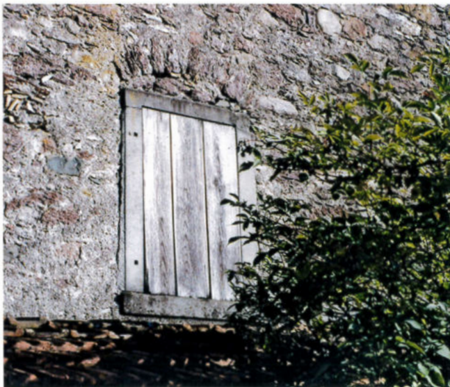
An der Wetterschutzmauer des WAGNER-HEIRI-Hauses sind die Überwölbungen der Fensterstürze noch mit Feldsteinen gemauert.
