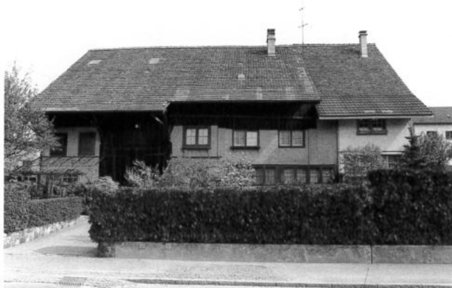
Das KELLER/KOHLER-Haus ist ein typisches mehrfach umgebautes und entlang dem First erweitertes Bauernhaus. Es ist aufgrund von eindeutigen Konstruktionsresten – neben dem Speicher GNEPF – das einzige in Unterengstringen noch nachweisbare Bohlenständerhaus. Bohlenständerhäuser waren vor dem 19. Jahrhundert über lange Zeit die übliche Bauform des hiesigen Bauernhauses. P.W. 1981
