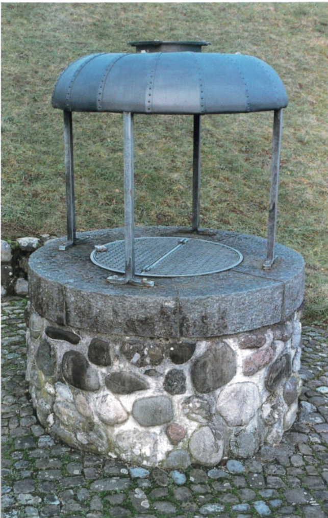
Der von der Gemeinde renovierte Sodbrunnen vor dem Meierhof des Klosters Fahr.
