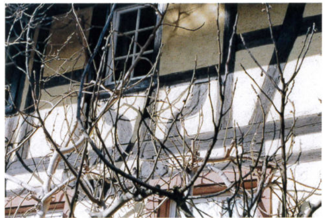
Als Ausnahme sind am Hause Gohl neben geraden auch vereinzelt S-Riegel eingesetzt worden.
