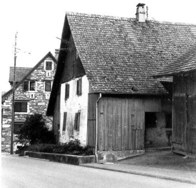
Das GUYER/SCHWERZMANN-Haus (Aufnahme 1978) war bis zur grossen Renovation 1979/80 verputzt, d. h. die Riegel überpflastert. Bergwärts neben dem Haus stehen die zwei Ökonomiegebäude der beiden Hausteile. O. M.
