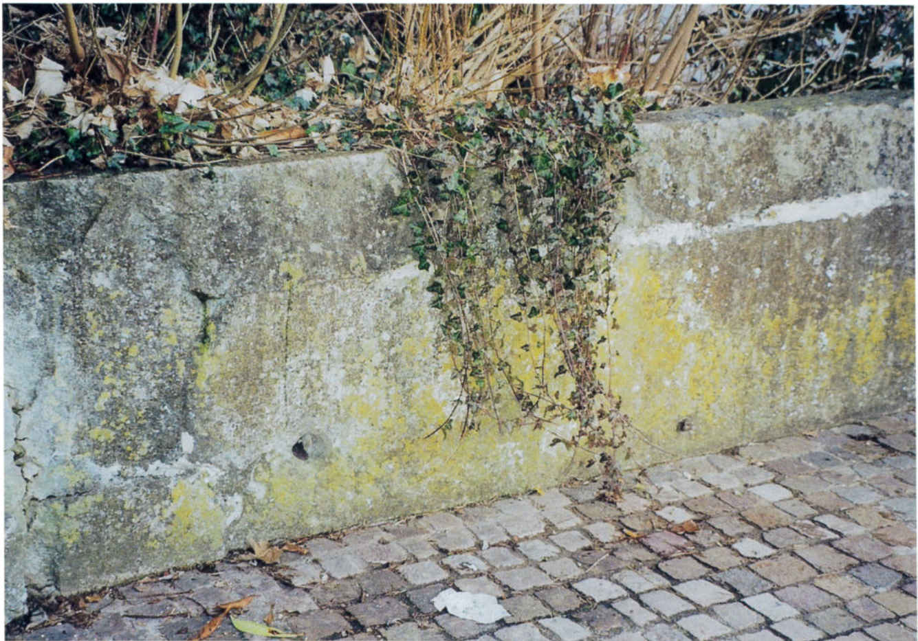
Die Abgrenzungsplatte (abgetragen im Januar 2010) bei der Brunnenstud des mittleren Dorfbrunnens war ursprünglich die Grundplatte eines Brunnentroges und trug auf der Oberseite die Jahrzahl der Erstellung aller drei Dorfbrunnen: 1755.
