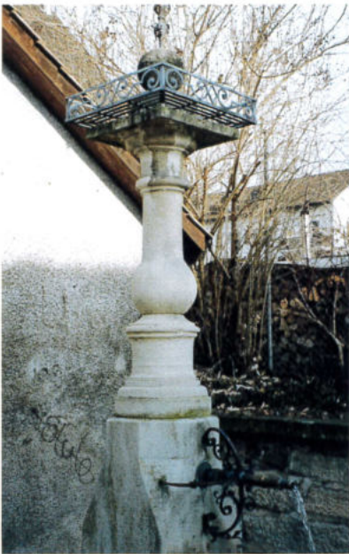
Die Brunnenstud des vorderen Dorfbrunnens besteht im Oberteil immer noch aus dem ursprünglichen Würenloser Muschelkalkstein.
