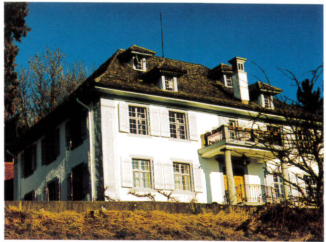
Haupt- und Westfassade des Herrenhauses (1997)
