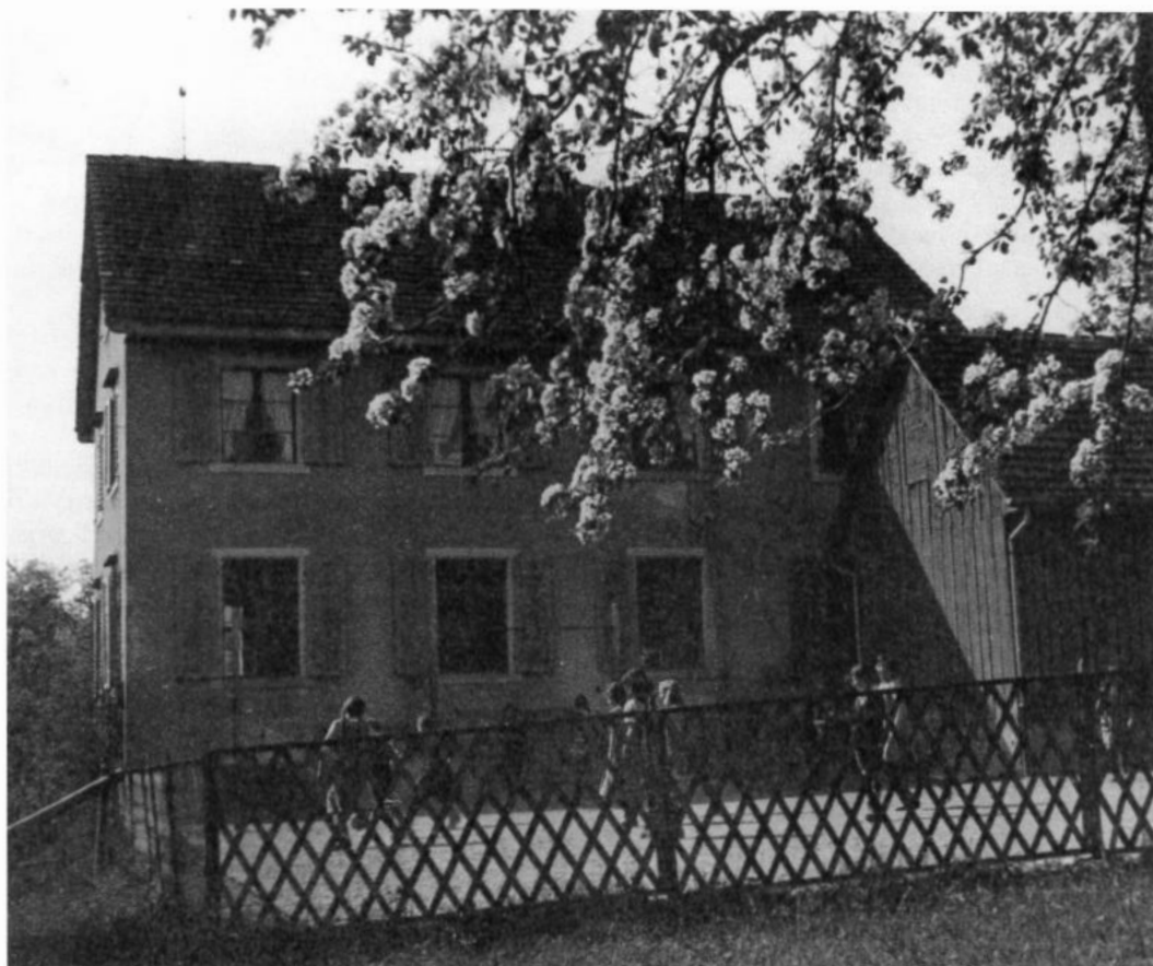
Das alte Schulhaus im Zustand vor dem Anbau 1927/28 (Ostansicht)
