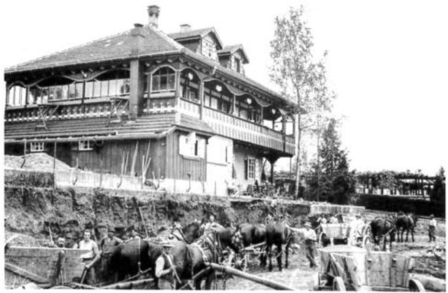
Der Sennenbühl im Jahre 1933 Im Vordergrund der von JAKOB MEIER-EHRSAM, d.h. dem Grossvater des Verfassers, organisierte Aushub für den grossen Saal mit Pferdefuhrwerken.
