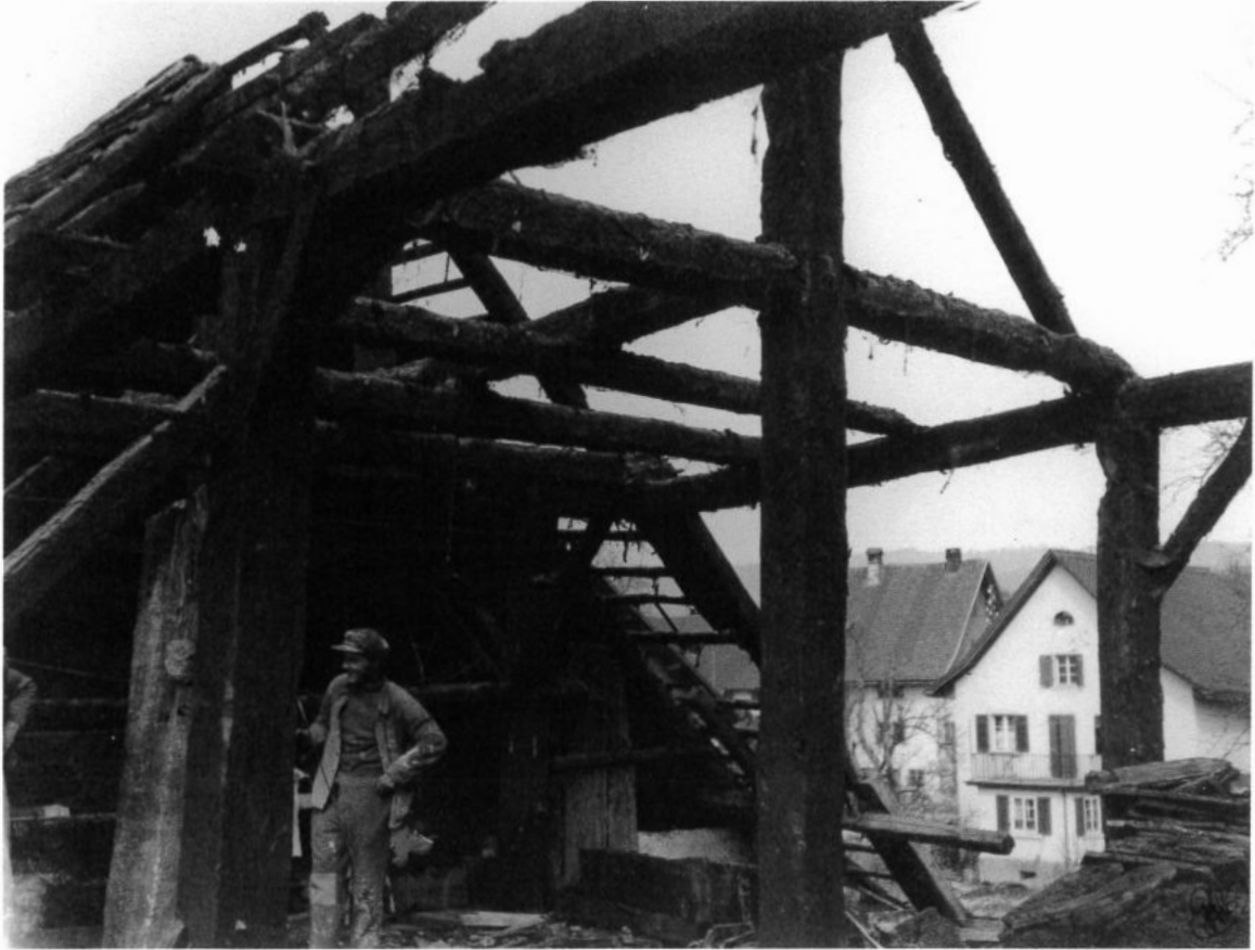
Blick vom ausgebrannten Dachstock des mittleren «Chläggihauses» (alte Schulstrasse Nr. 15) auf mein Elternhaus. Bereits war im Parterre die Veranda angebaut worden und vor dem Elternzimmer im ersten Stock hatte es eine Terrasse zum Lüften und Sonnen des Bettzeuges. Links vom «MILCHMEIER-Haus» erkennt man das Haus der Gebrüder BENZ, d.h. dem HERRMANN oder «STÜRMIBENZ» und dem «Uhrmacher BENZ» (heute Standort des Feuerwehrgebäudes).
