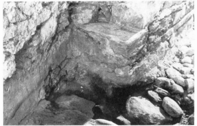
Abb. 3 Unterster, nicht zurückgeschoteter Sandsteinquader an der Westwand des nördlichen Chorbogenpfeilers mit anhaftendem Deckverputz. Links davon zeichnet sich im Wandverputz die Stufe zum Chor ab.
