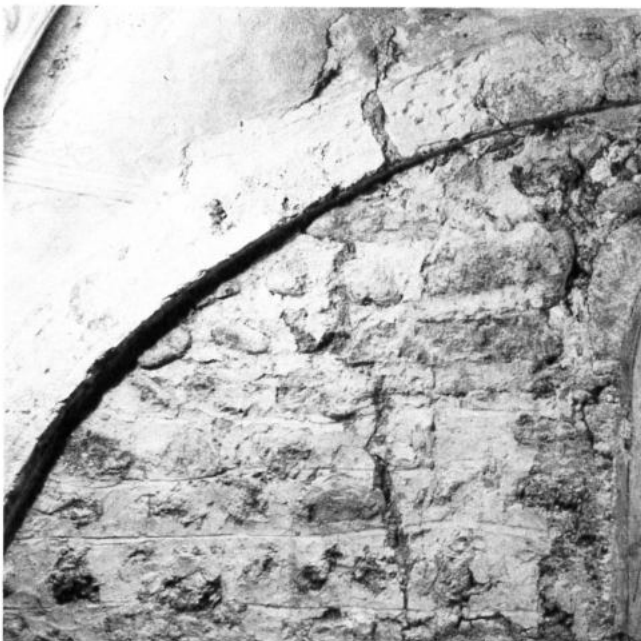
Abb. 4 Bogenfeld an der Südwand im Chor, nach der Entfernung des Malputzes von 1930. Dieser «pietra rasa»-Verputz mit Fugenstrich geht vor den romanischen Malmörtel (Schicht 5) zurück. Er wurde 1930 zum Teil entfernt.
