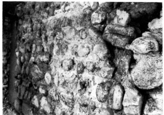
Abb. 8 Originalverputz mit Fugenstrich und gelber Kalkung an der Langhausnordfassade.
