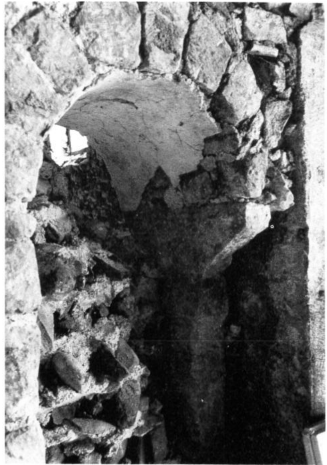
Abb. 7 Gekuppeltes Rundbogenfenster, Detail Säule und Kämpfer.
