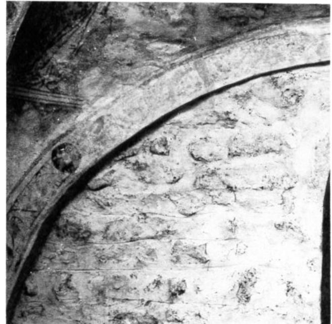
Abb. 5 Dasselbe Wandstück nach den Putzergänzungen. Der romanische Fugenstrich wurde in den Fehlstellen nicht ergänzt.
