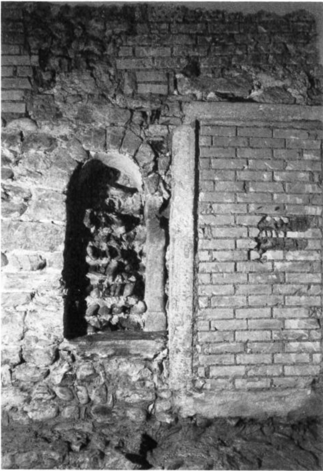
Abb. 6 Gekuppeltes Rundbogenfenster der ehemaligen Vorhalle.
