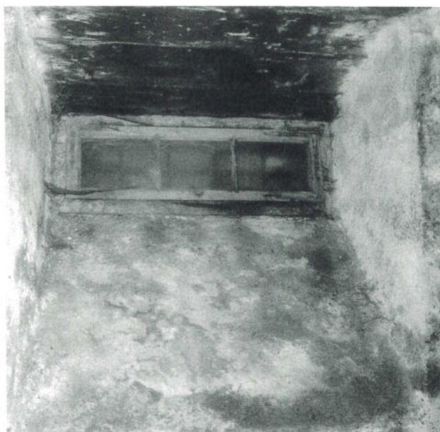
Ein Kelleroblicht (Kellerfenster), von Glaser Geering 1849 verglast, lässt auch heute noch spärliches Licht durch die 1.10 m dicke Mauer in den Keller fallen.
