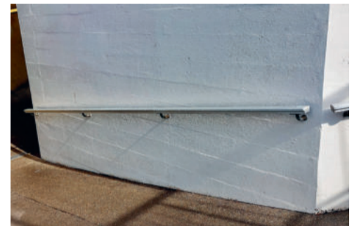
Reinigung der Unterführung (vorher/nachher)
