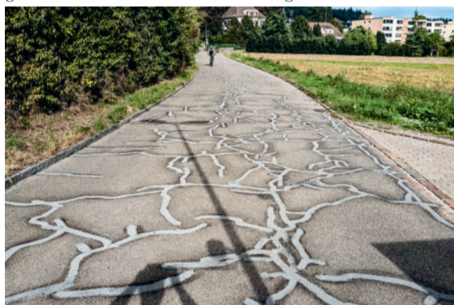
Chriesihogerweg nach Risssanierung
