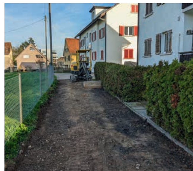
Erstellte Planie für Belagseinbau
