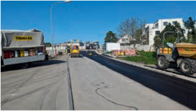
Wechseläckerstrasse nach Belagseinbau
