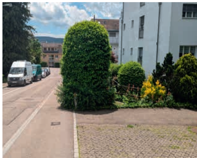
Hydrant in Gebüsch eingewachsen
