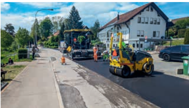
Belagseinbau in Weizenächern
