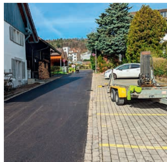
Stolzweisstrasse mit neuem Belag
